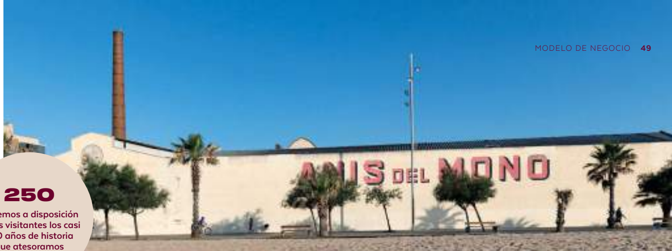
Destilería Anís del Mono en Badalona, Barcelona.
